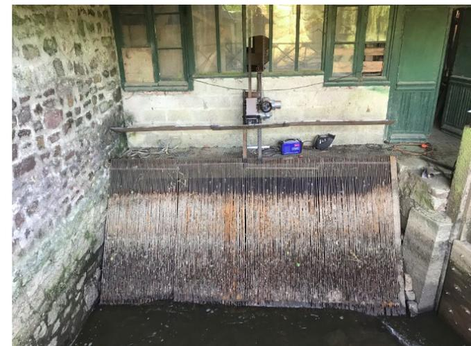
Le filtre grille qui retient les déchets du fleuve détourne également la faune aquatique vers les organes de franchissement (passe à poisson et déversoir) par des lames d'acier doux de 5 x 45 x 2000 mm espacées de 20 mm et inclinées de 56°, en cours de remplacement par des lames d'acier inoxydable de nuance 316 et de dimensions 5 x 30 x 2000 mm.
