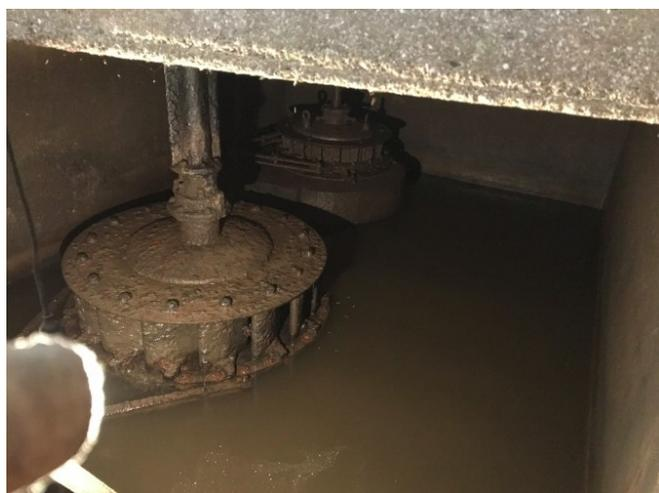
La chambre d'eau était équipée de deux turbines verticales de type Francis de 22 kW (devant) et 7 kW (au fond) qui transformaient l'énergie potentielle de pesanteur de l'eau (chute brute de 2,10 m) en énergie mécanique.
